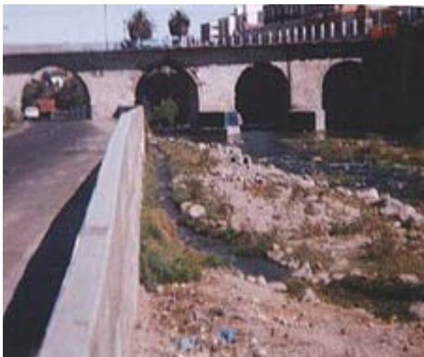
Figura 5. Estación II-A. Puente Bolognesi.
