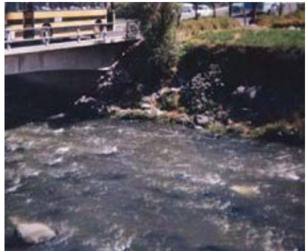
Figura 4. Estación III. Puente Vallecito.
