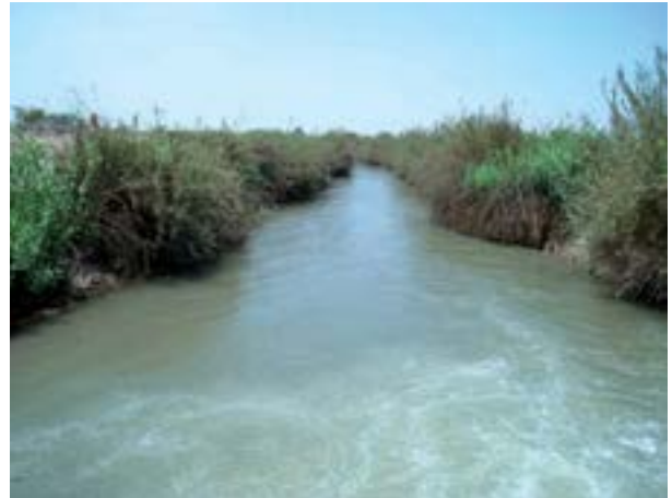
Figura 5. Canal de riego en el área de Ica (Perú), construido en la época incaica (hace 5 siglos) y que durante todo el año provee abundante agua proveniente de los Andes (lluvias y deshielo).
