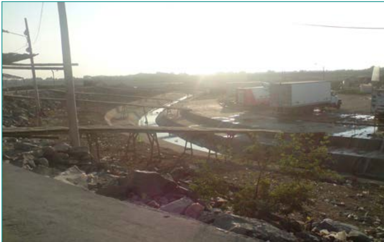
Fotografía 1. Foto panorámica desde lado ecuatoriano: canal internacional en Playa Sur, donde se aprecian los puentes provisionales de madera para el traslado de pescado 17 entre Perú y Ecuador.
