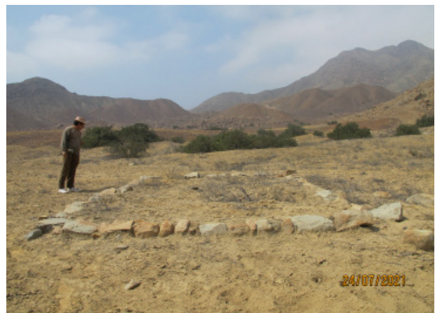
Construcción de simientos
