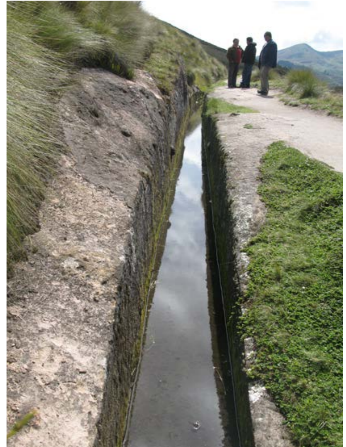
Figura N° 14. Línea recta, de culminación del segmento I del canal.
