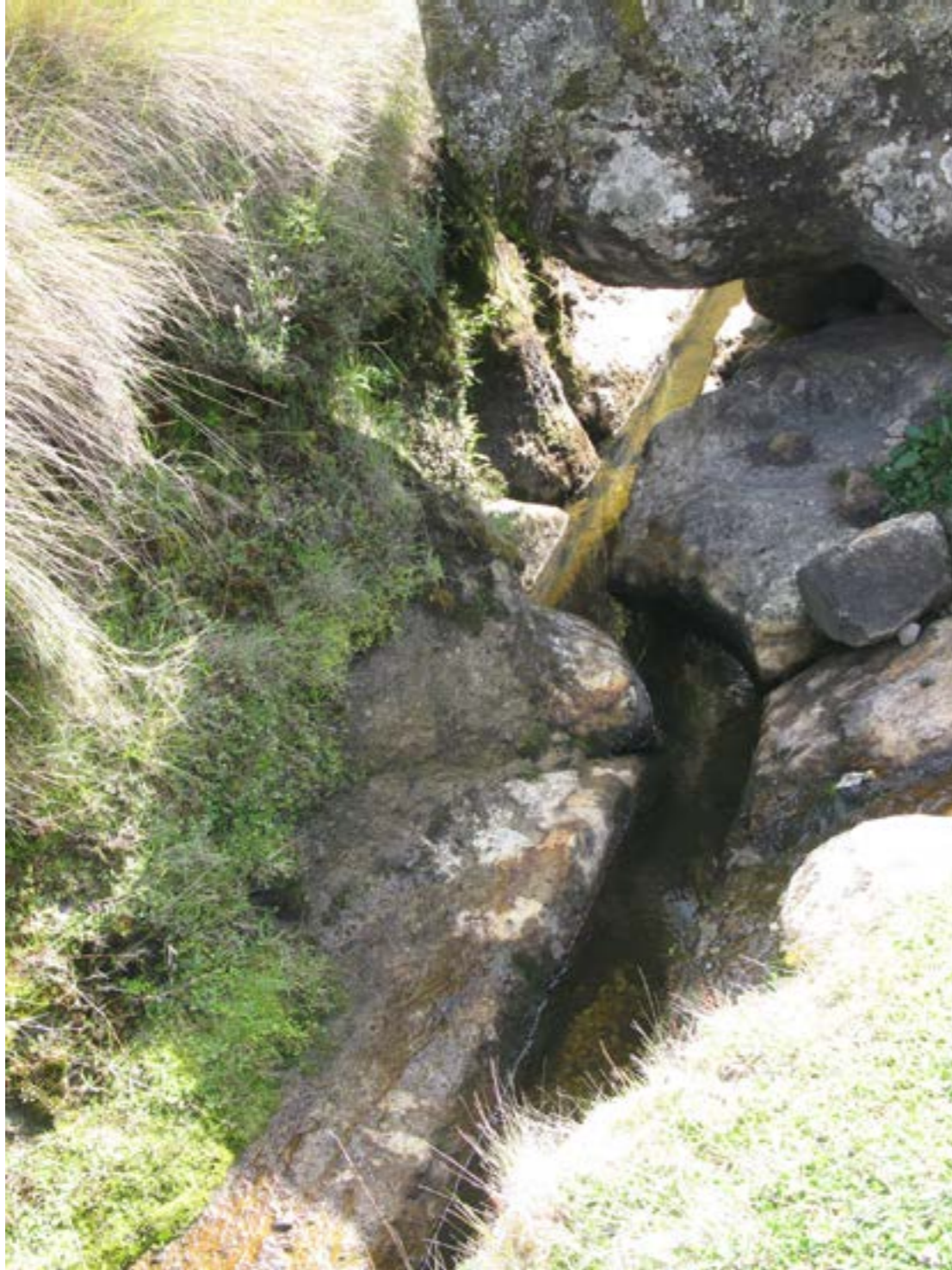
Figura N° 11. Trazos en la roca del Segmento I del Canal.
