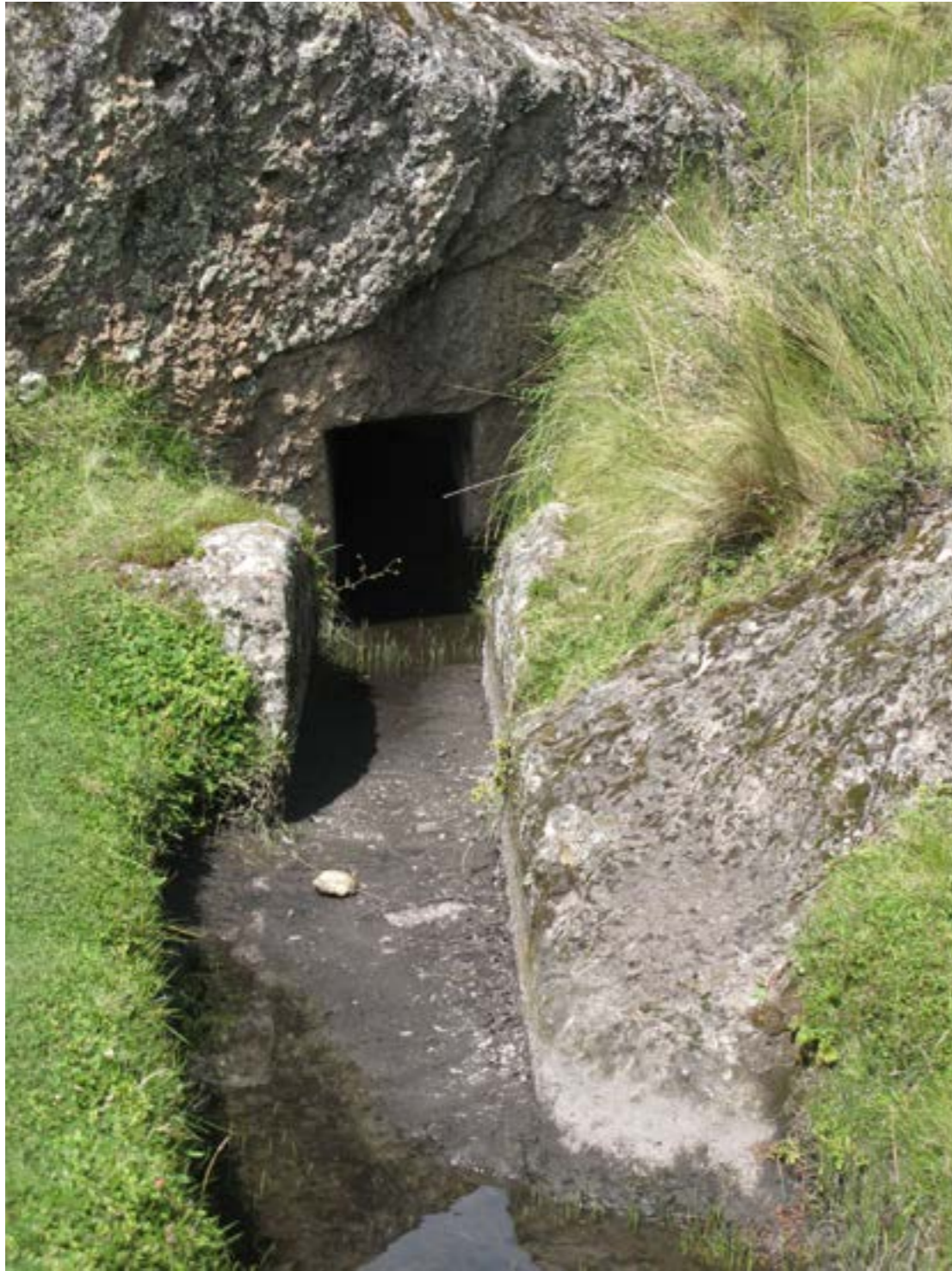
Figura N° 19. Salida del Boca rectangular, del túnel. (0.80x0.60m. de alto)
