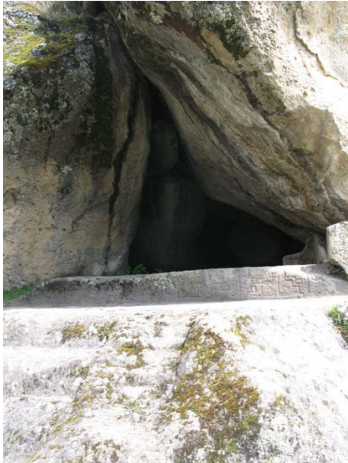
Figura N° 21. Tercera cueva ubicada en el Segmento II del canal, en la base del frontis se observan petroglifos.
