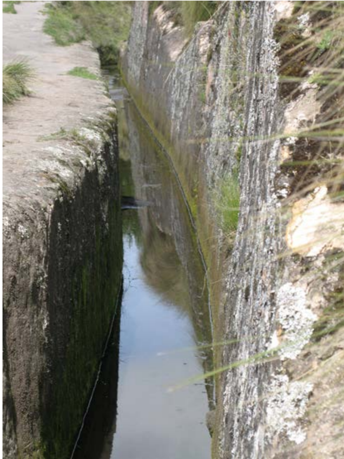
Figura N° 13. Roca tallada para la continuidad del canal manteniendo la pendiente de 0.001,5 mm
