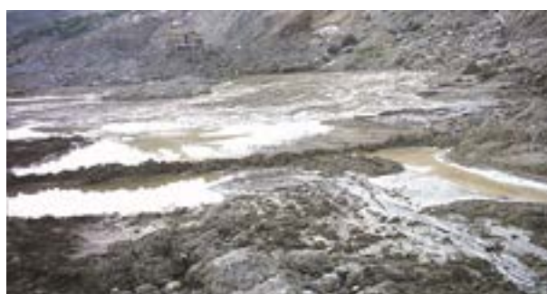
Figura 2. Argilitas afloradas por la elevación del nivel freático.
